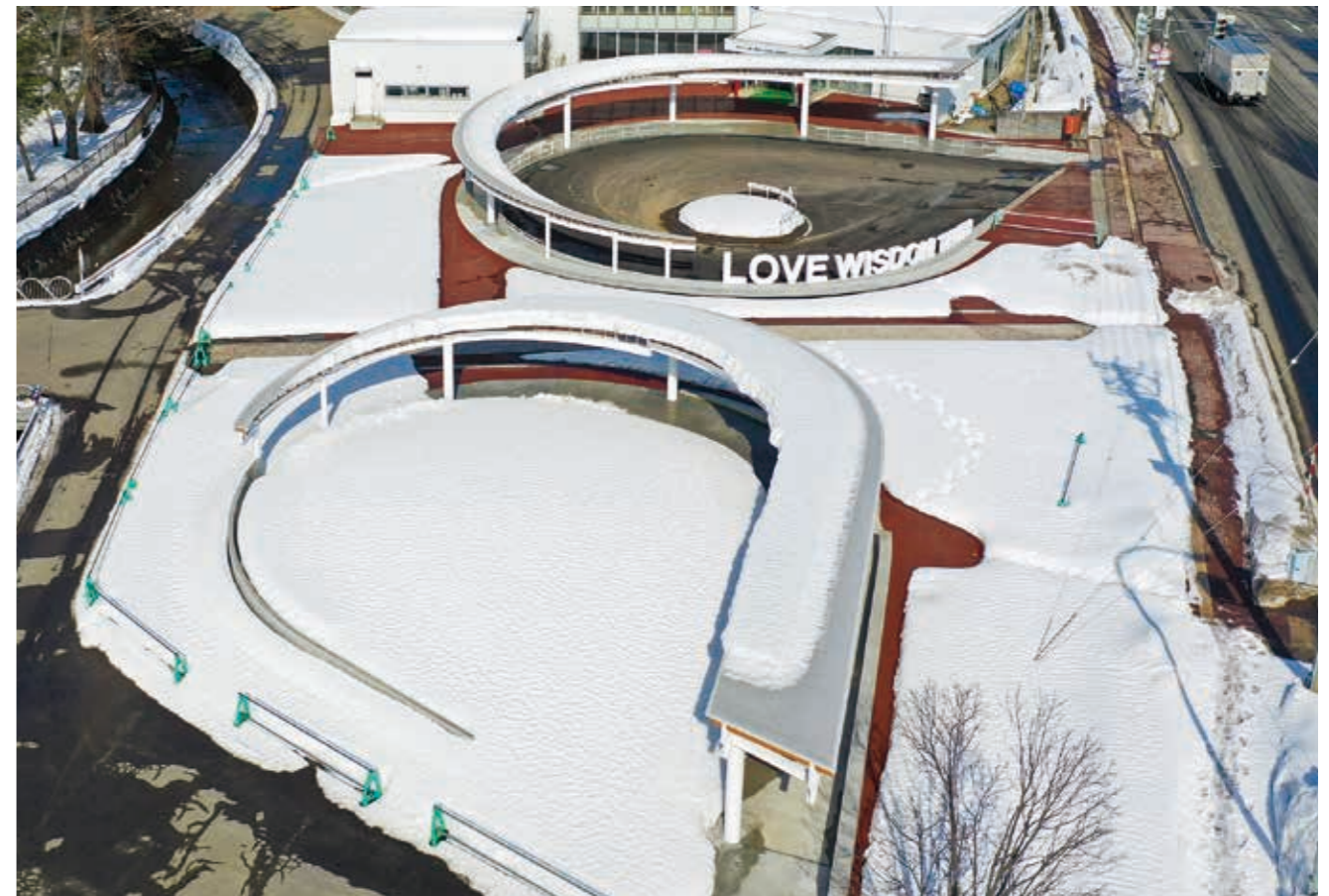
一部の通路とロータリーに地下水熱を利用した融雪設備を埋設した
