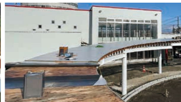
野地板に防水シートで仕上げ
