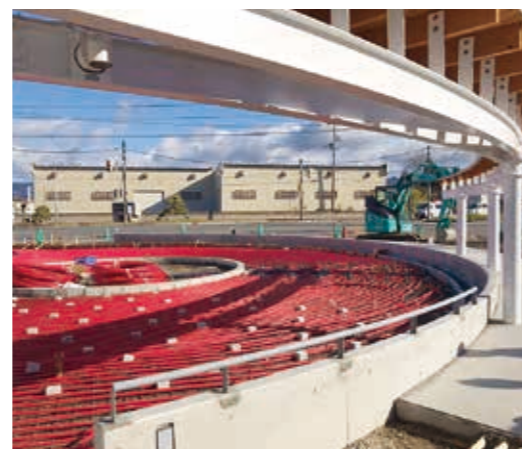
融雪パイプ敷設時の様子
