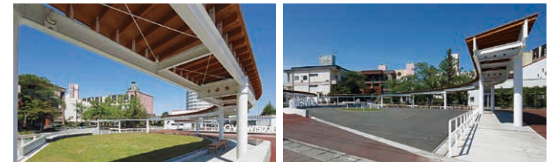
芝の丘とそれを囲む鉄骨造の柱や梁と木製の庇
