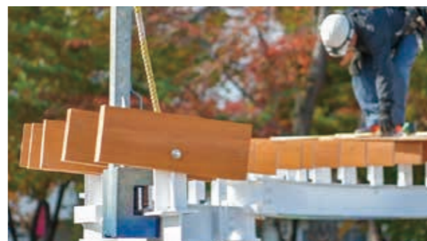
母屋は現場で1本ずつ取り付け
